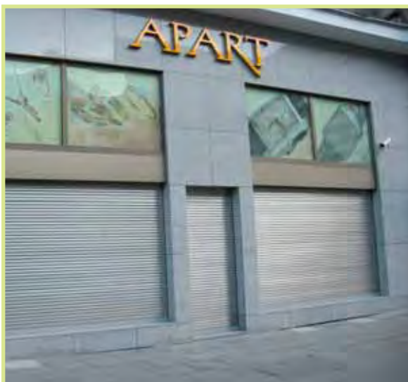
Schaufenster mit einbruchhemmenden Rollläden
